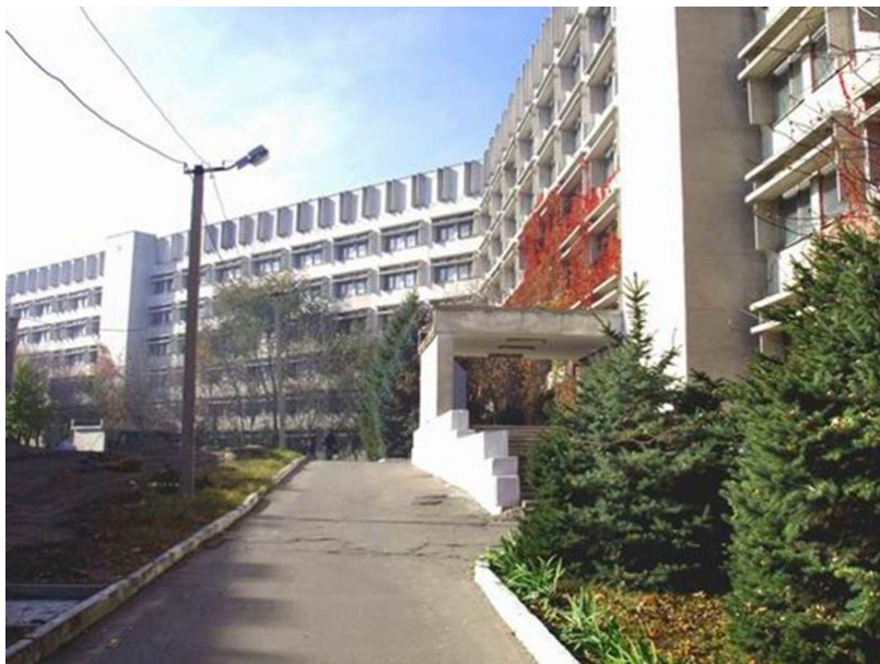
Корпус №16 Дніпровського національного університету ім. О. Гончара, в якому зараз розміщується хімічний факультет
